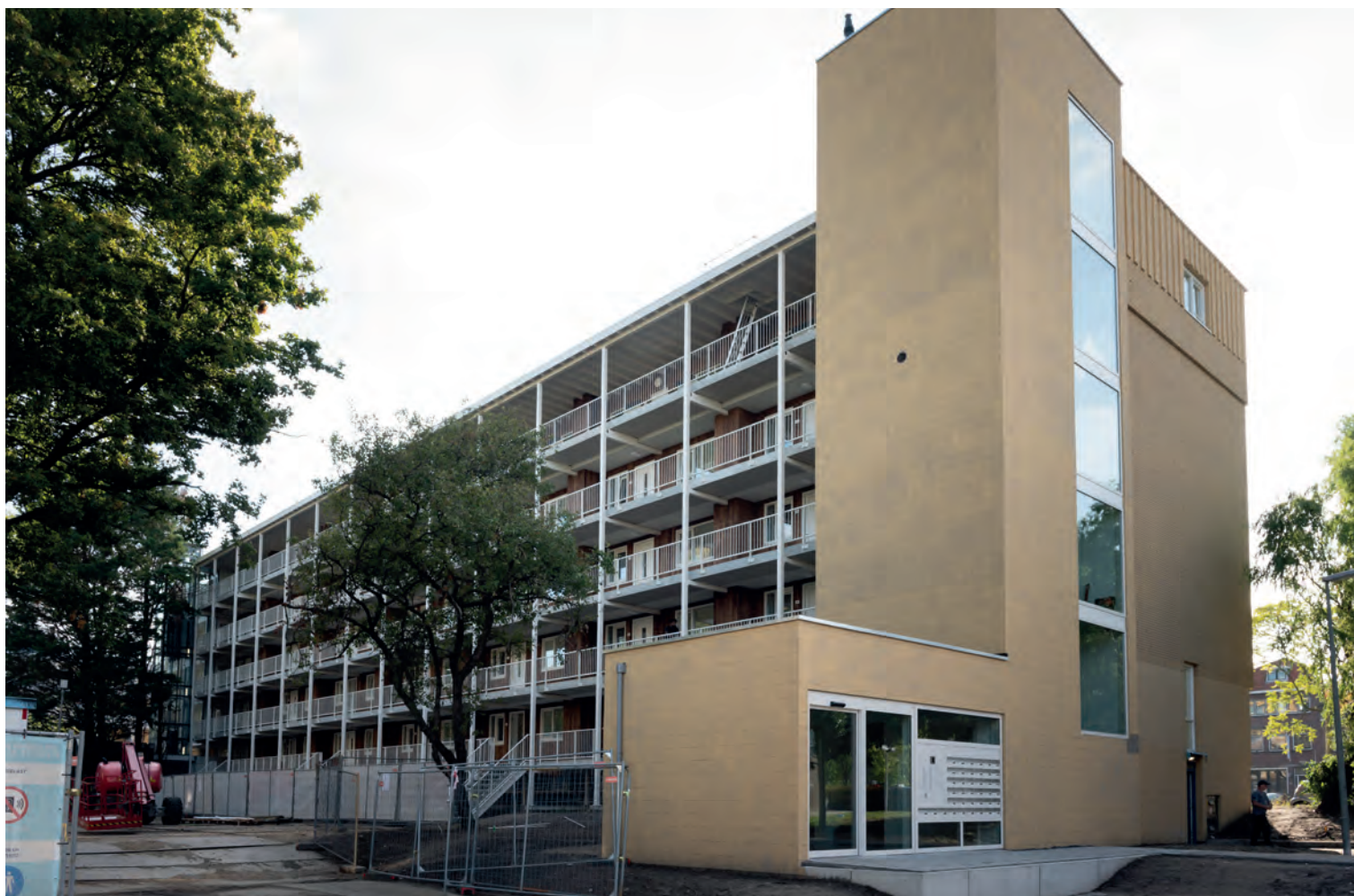
De galerijzijde van de gerenoveerde flat. De nieuwe entree is aan de achterzijde van het gebouw geplaatst, inclusief rolstoel-vriendelijke lift.
